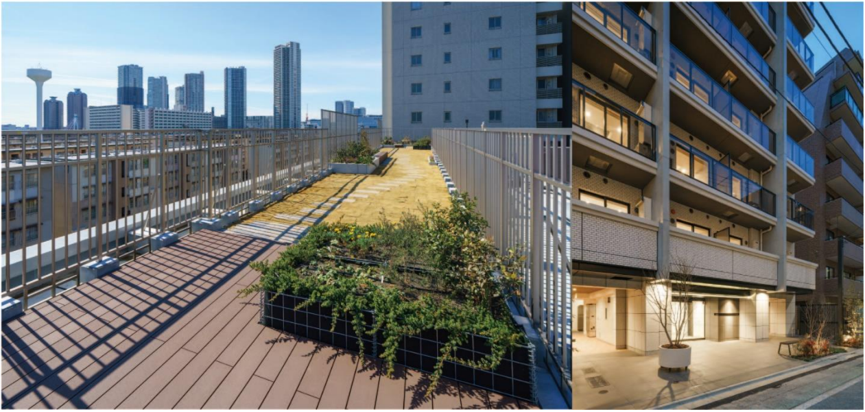
TATSUMIスカイガーデンテラス (屋上テラス)
